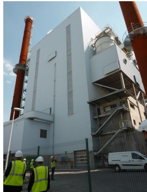
Figure 43 – Photographie de l'unité de cogénération de la papèterie Smurfit Westrock à Biganos Source : ALEC
